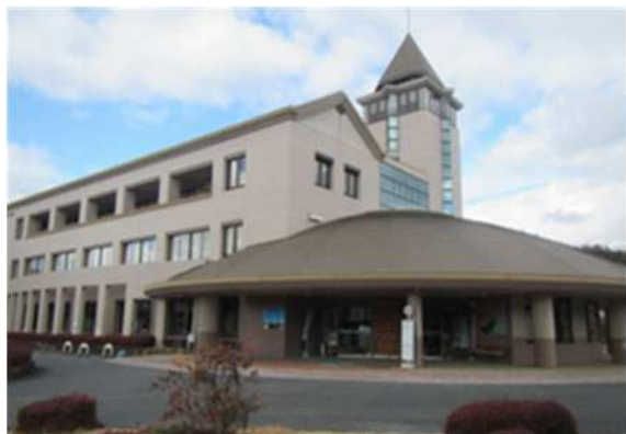
【美星支所庁舎】 (美星図書館との複合施設)
