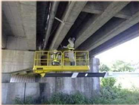
橋梁点検車などを使用した点検状況
