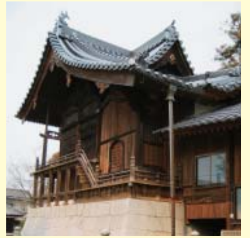
武速神社 社殿は江戸時代末期、塩飽大工の棟梁・茂兵衛が建立したとされる。とりわけ本殿基礎部分の石垣は細密な細工で組み上げられているのが特徴。
