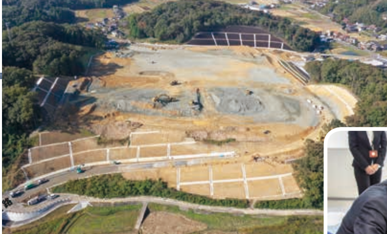
▲工事が進む稲倉産業団地
