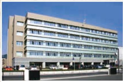
▲⑫平成15年7月、新庁舎完成
