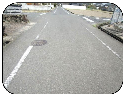
【路上のマンホール】
