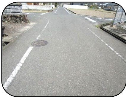
【路上のマンホール】
