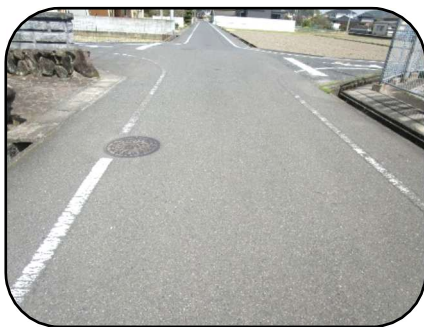
【路上のマンホール】
