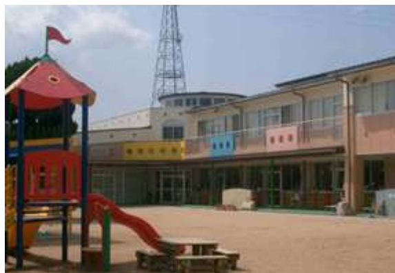
【西江原幼稚園】 (甲南保育園・西江原幼稚園・ 西江原公民館との複合施設)
