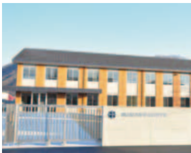
市立高等学校校舎の新築
