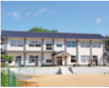
青野小学校管理棟を改築
