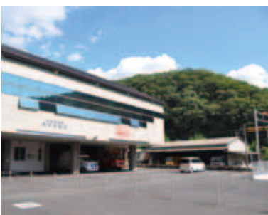
芳井分駐所を改築移転(井原地区消防組合負担金)
