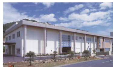
写真：岡山県西部衛生施設組合
