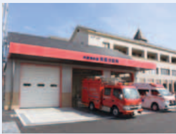
美星分駐所を改築移転 (井原地区消防組合負担金)
