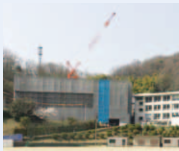
井原中学校建設事業 (南校舎解体・特別教室棟建設着手)
