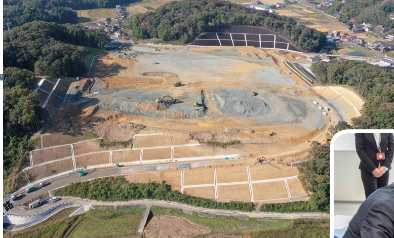
▲工事が進む稲倉産業団地
