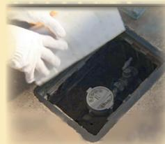
露出した水道管に保温材や毛布、布きれなどを巻きます。特に、蛇口は破裂しやすいので、上まで完全に包みます。
