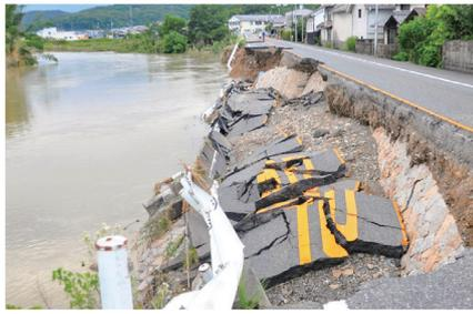
▲**18**平成30年7月豪雨により西江原町地内の国道486号が崩落
