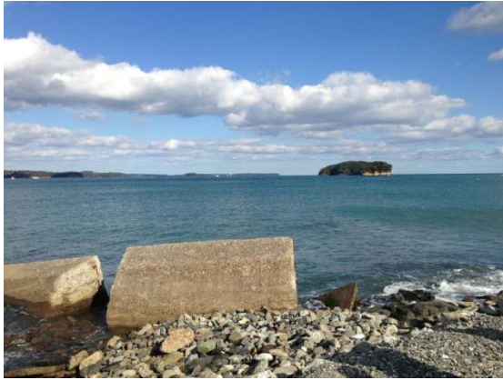
破壊された防波堤
