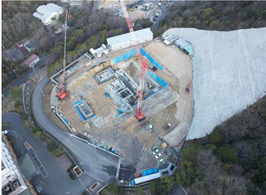
西部衛生施設組合 新焼却場（建設中）
