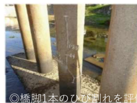
◎橋脚1本のひび割れを評価
