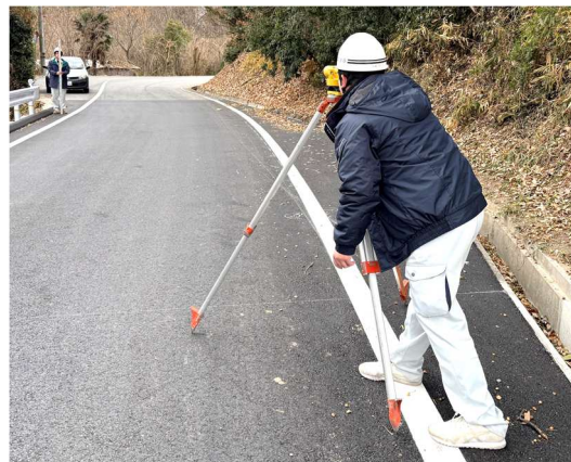
▲道路工事予定地となる場所の基礎データとなる 測量調査を行っています。
